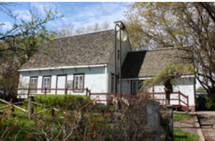
Figure 28 ] type de bâtiment est généralement implanté sans égard à la voie publique et sa façade principale est orientée vers le sud pour bénéficier d'un maximum d'ensoleillement. La maison Éphraïm-Bédard en constitue un bon exemple (fig. 28).
