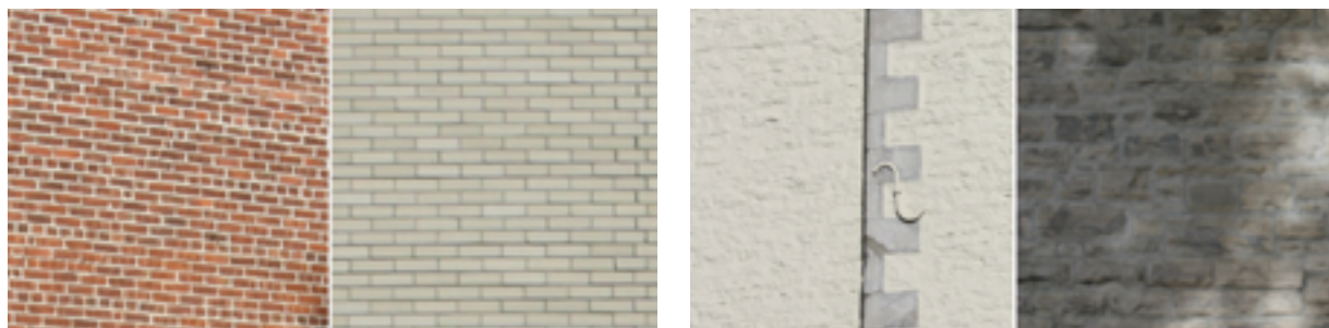
Maçonnerie de pierres
