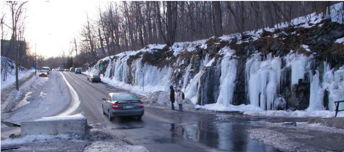
Absence de trottoir sur un segment de rue qui menait à un hôpital pour enfants
