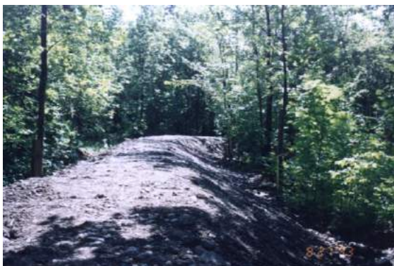
Digue pendant les travaux de construction
