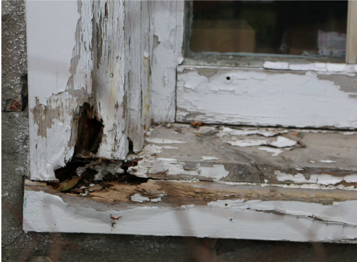
Détail de la fenêtre visible de la rue
