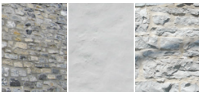
Maçonnerie de pierres
