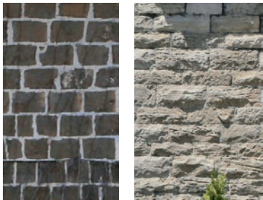
Maçonnerie de pierres
