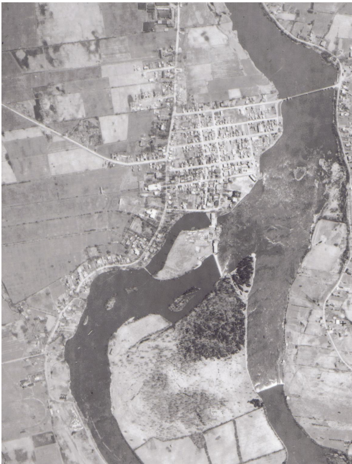
Annexe 2 : Photo aérienne du « village » de Terrebonne en 1931
